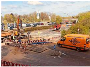
Die Wilhelmstraße muss teilweise gesperrt werden. FOTO: STADTWERKE
